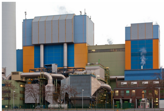
↑ 一般机械-焚烧炉
